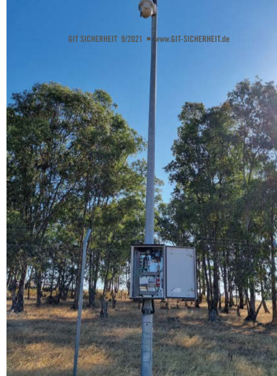
▲ Solarpark-Perimetersicherungslösung mit durch Slat DC-USV-gepufferter Videoüberwachung
