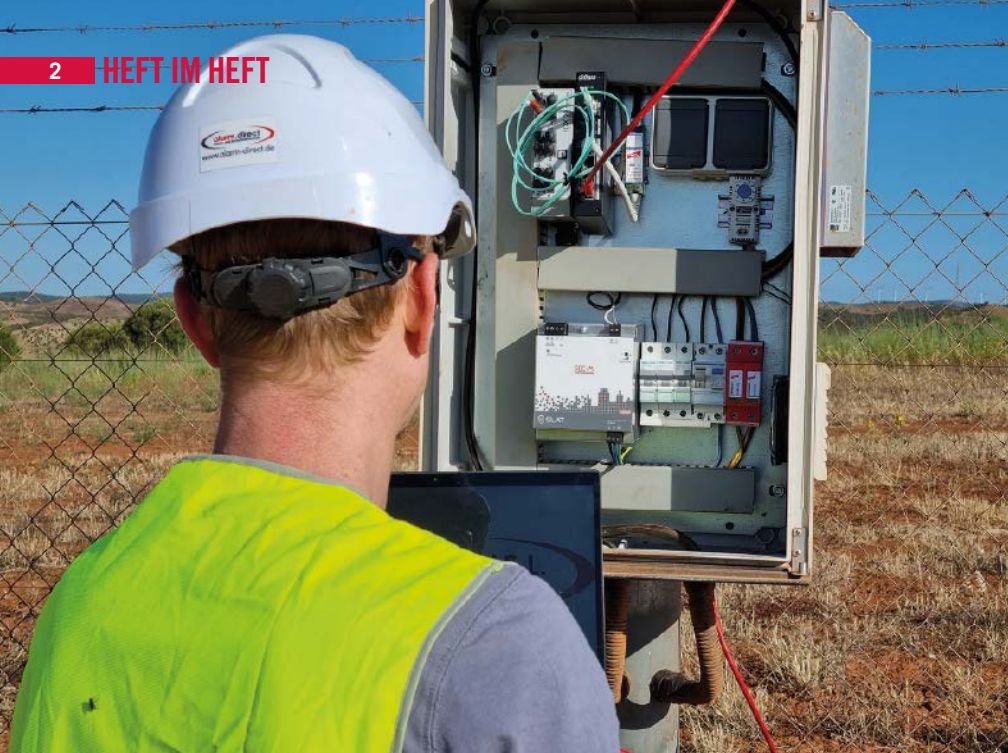
▲ Slat Mikro-USV vom Typ SDC-M 48V DIN2 R5 sichert den zuverlässigen Weiterbetrieb der angeschlossenen Geräte bei Netzausfällen und Mikrounterbrechungen
