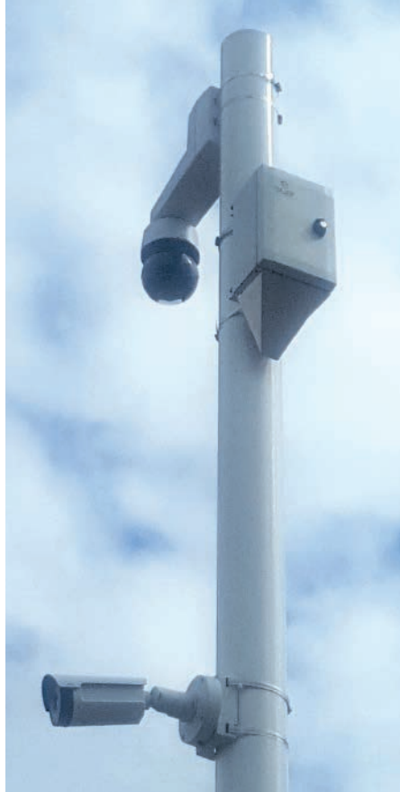
Gefahrenerkennung: Synaps 24V 3E IP von Slat versorgt und puffert bewegliche Dome-Wärmebildkameras von Axis
